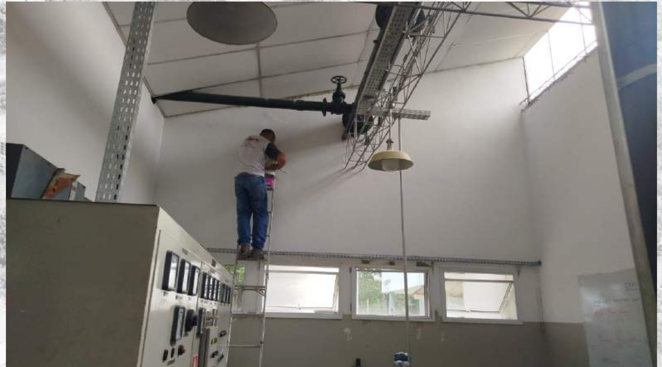
DEPOIS - REPARO DE TELHADOS E PINTURAS
