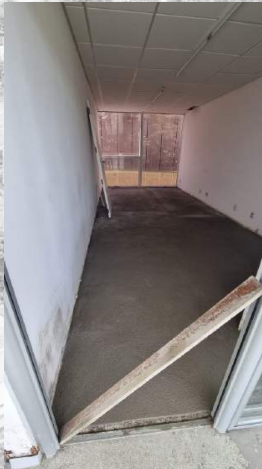
REALIZAÇÃO DE CONTRAPISO
