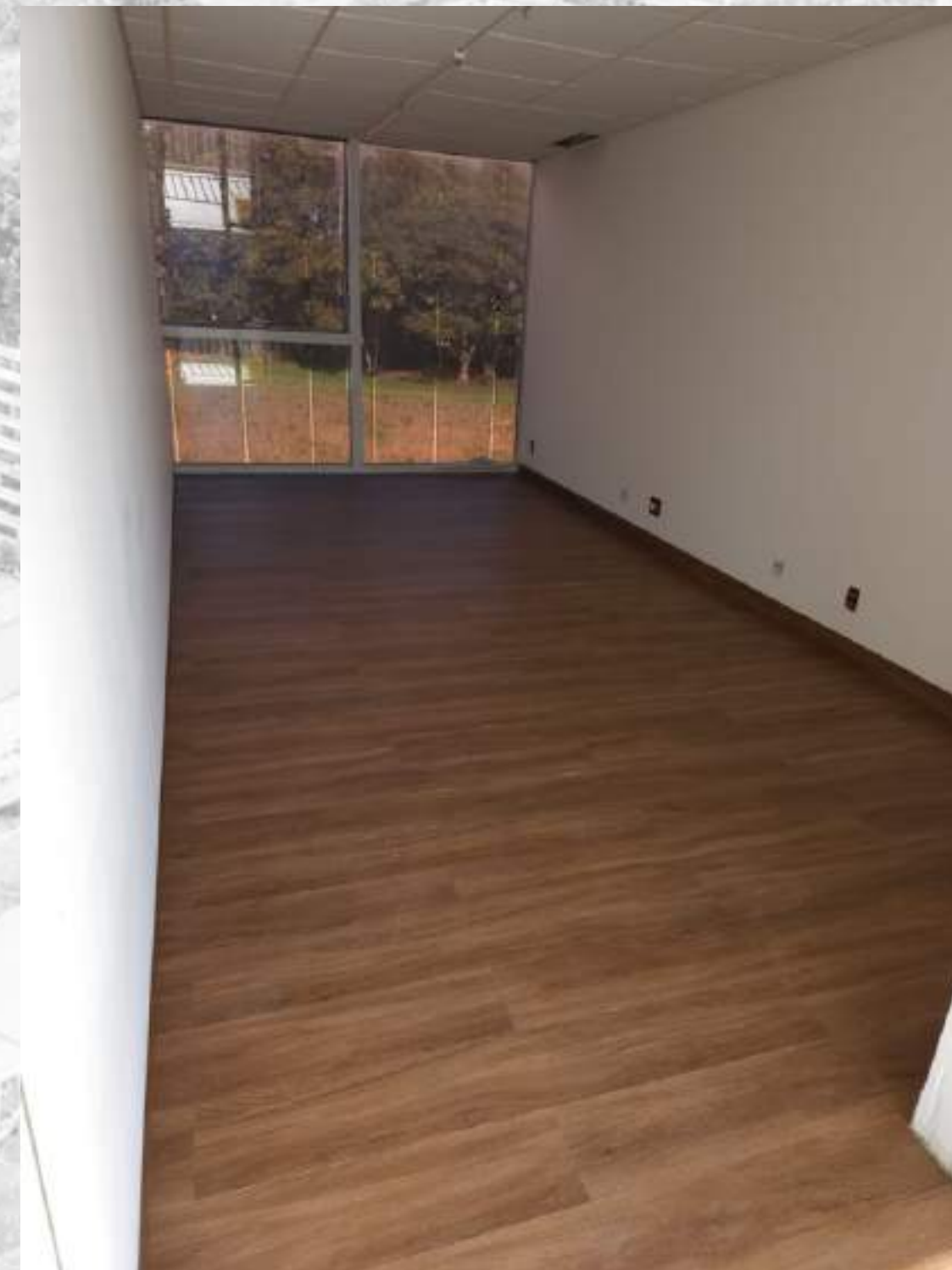
APLICAÇÃO DE PISO VINÍLICO
