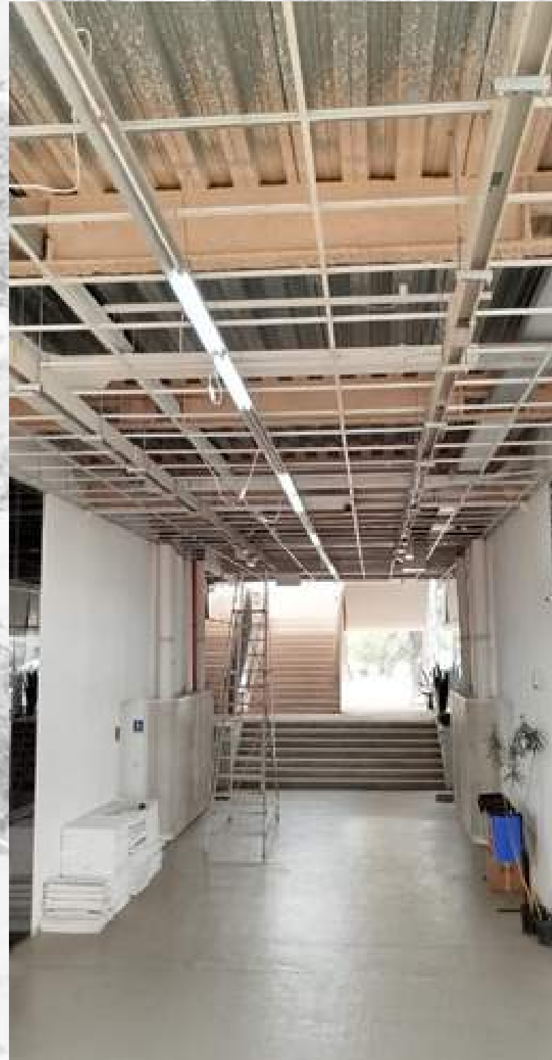
SUBSTITUIÇÃO DE FORROS- ANTES
