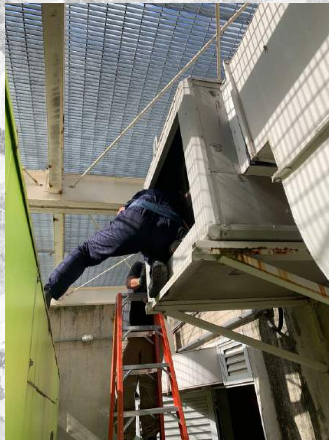
SERVIÇOS ELÉTRICOS – REPARO NO SISTEMA DE VENTILAÇÃO DO GERADOR
