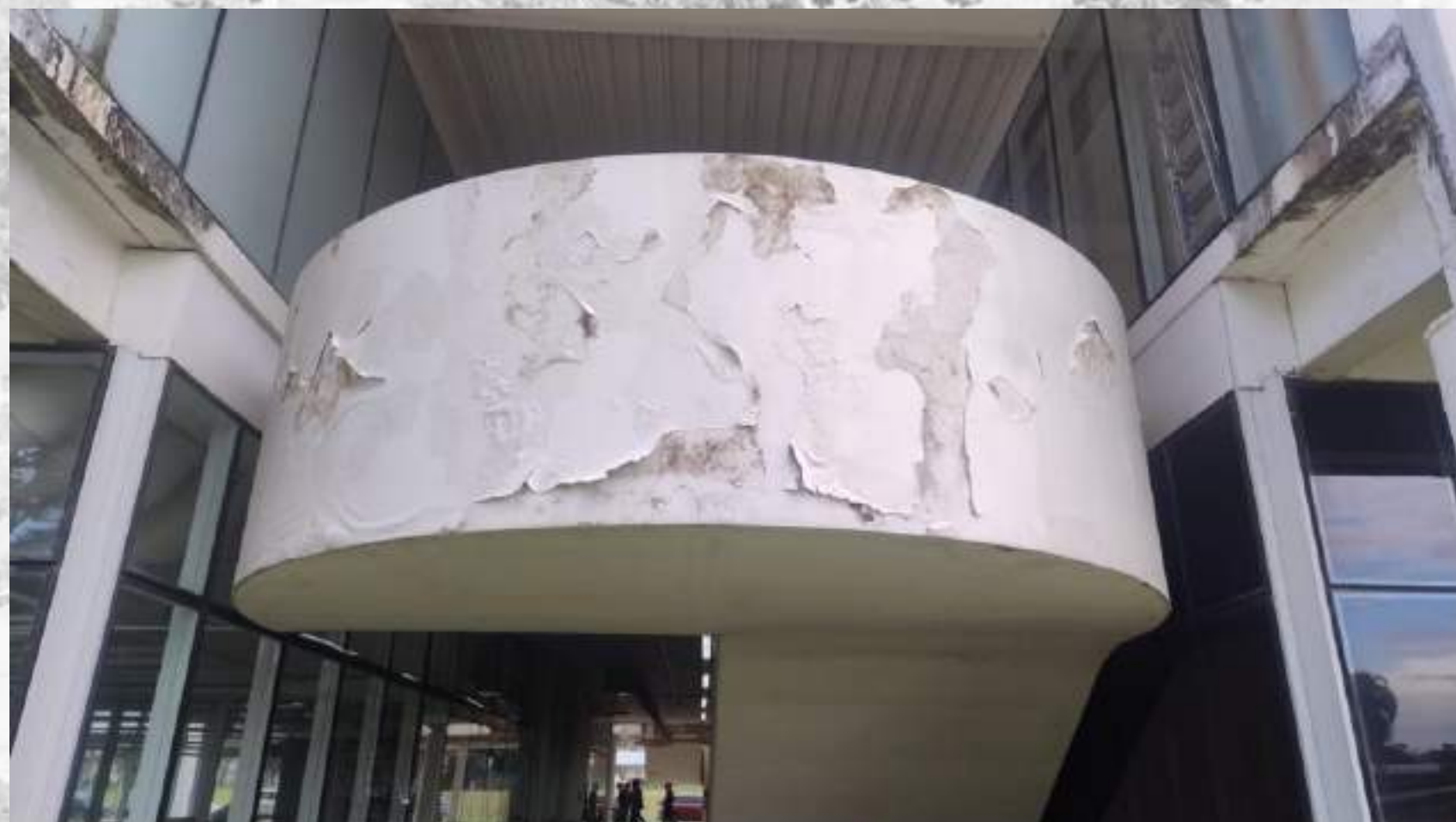
PINTURA ESCADARIA - ANTES
