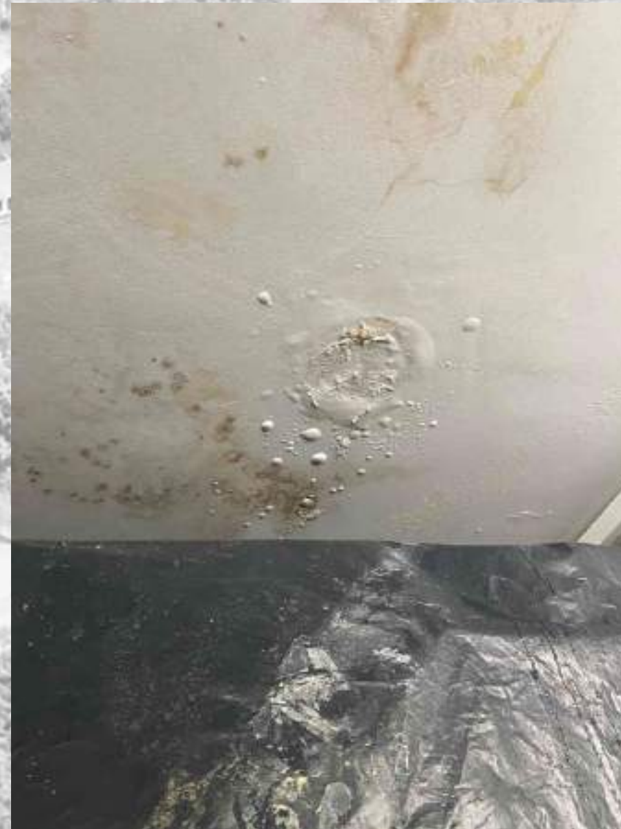
INFILTRAÇÕES PROVENIENTES DOS BANHEIROS
