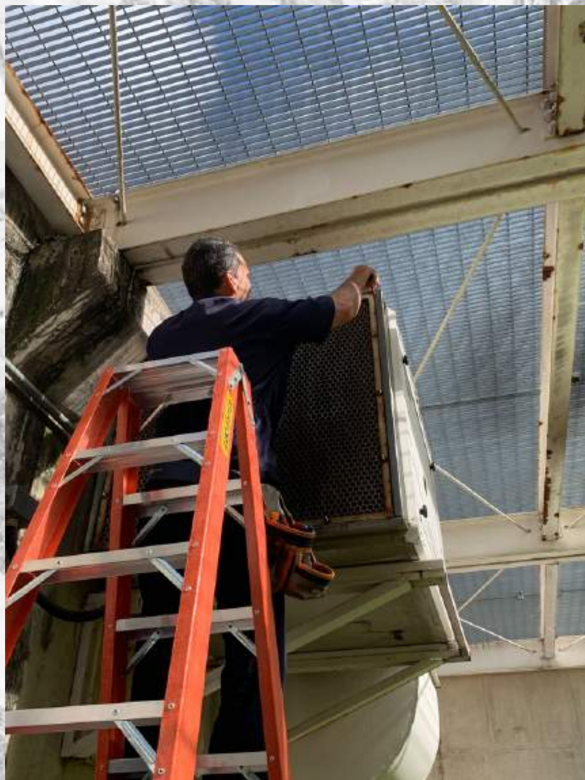
SERVIÇOS ELÉTRICOS – REPARO NO SISTEMA DE VENTILAÇÃO DO GERADOR
