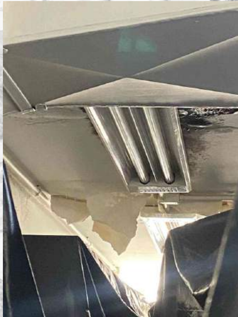
INFILTRAÇÕES PROVENIENTES DOS BANHEIROS
