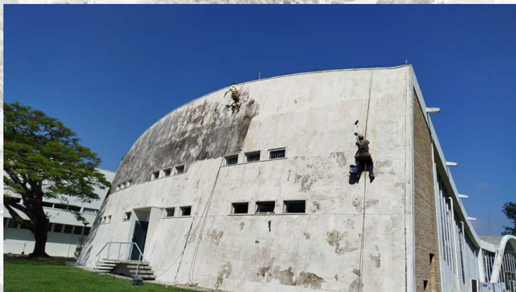
PINTURA EXTERNA - ANTES
