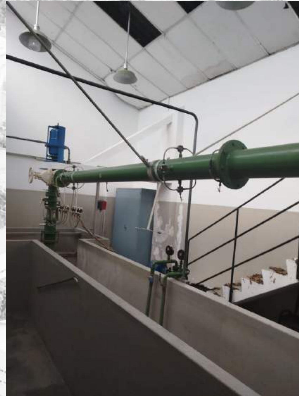
DEPOIS - REPARO DE TELHADOS E PINTURAS
