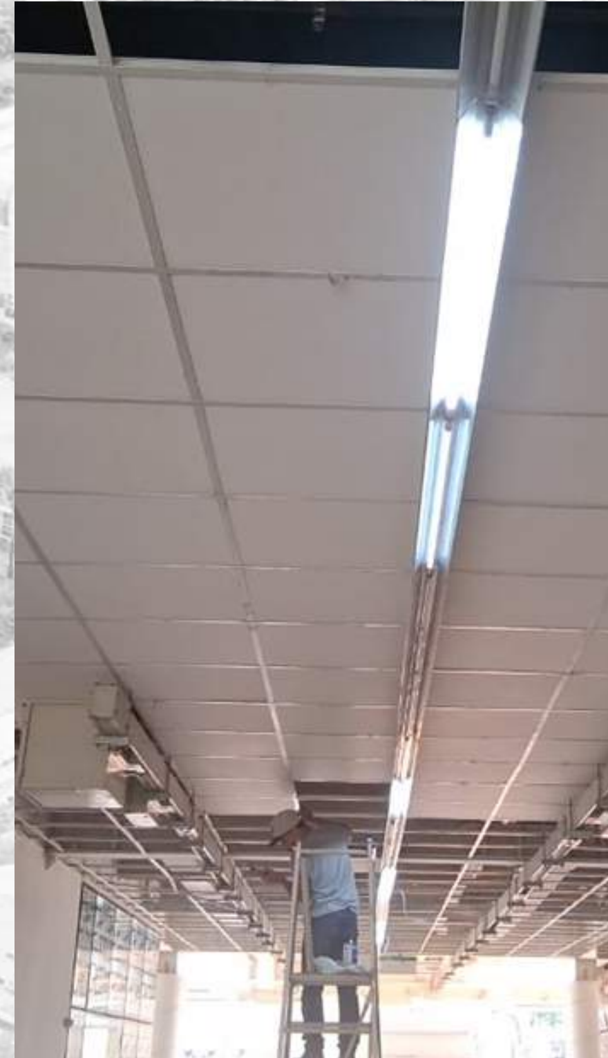
SUBSTITUIÇÃO DE FORROS - DEPOIS
