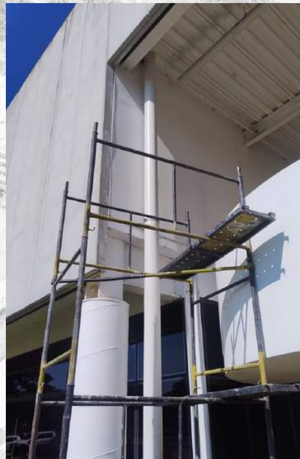
DEPOIS - INSTALAÇÃO DE DESCIDAS DAS CALHAS
