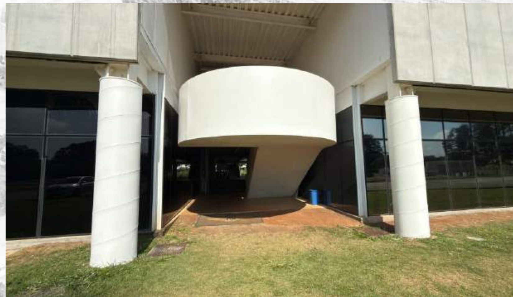
PINTURA ESCADARIA - DEPOIS
